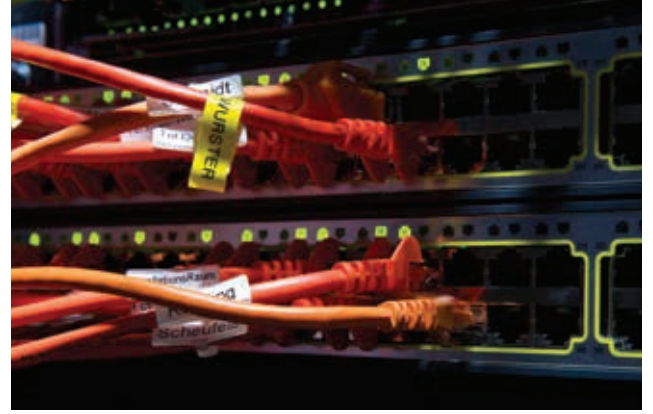
Kablo tanımlama için özel formatlar ve malzemeler: dikey ve yatay bayrak, kendinden laminasyonlu sarmaya uygun ve ısıyla Daralan Makaron
