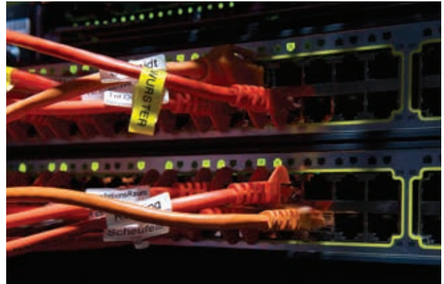
Formats et matériaux spéciaux pour l'identification des câbles : drapeau horizontal ou vertical, rubans stratifiés et thermorétractables
