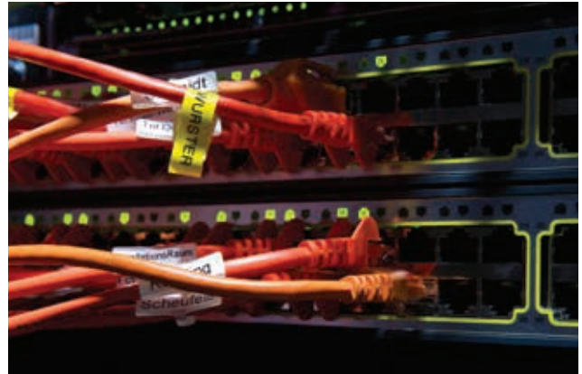
Ειδικά format και υλικά για ταυτοποίηση καλωδίων: κατακόρυφη και οριζόντια σήμανση, περιτύλιξη με πλαστικοποίηση και σωλήνες θερμικής συρρίκνωσης
