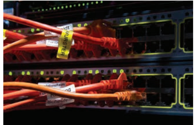
Specialformater og materialer til kabelidentifikation: lodrette og vandrette flag, selvlaminerende kabeltape og varmekrymperør
